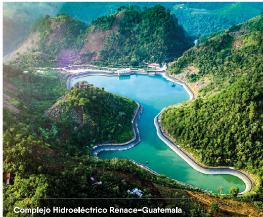
Complejo Hidroeléctrico Renace-Guatemala
