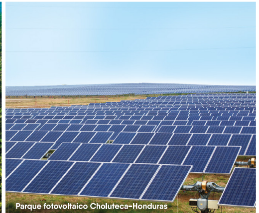
Parque fotovoltaico Choluteca-Honduras
